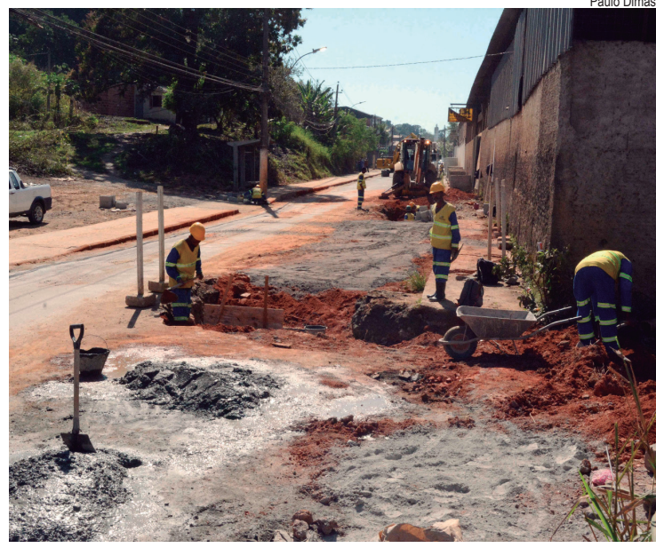
Neste trecho está sendo realizada a substituição e o redirecionamento de cerca de 63 metros de rede de águas pluviais
