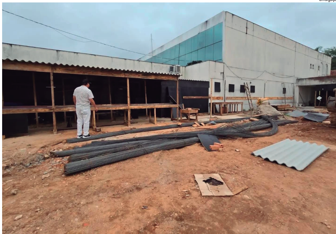
Luciano Vidal vistoriou obras do Centro de Hemodiálise e Casa de Parto Humanizado
