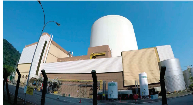
Legenda: Recursos serão investidos em sistema de segurança e modernização de sistemas e equipamentos para prolongar vida útil da usina
