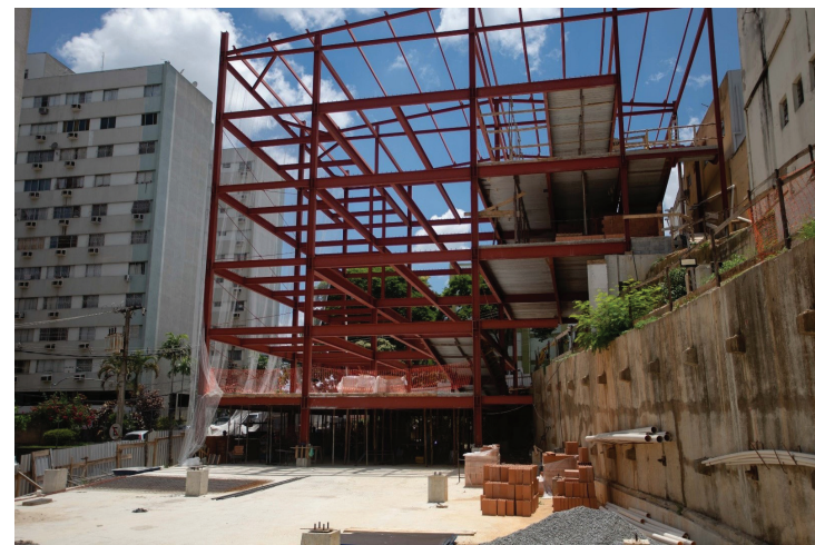
Próxima fase inclui instalação da tubulação de prevenção e combate a incêndios
